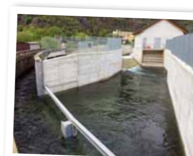
Kraftwerk Pallanzeno im Piemont: 1.100.000 kWh pro Jahr
